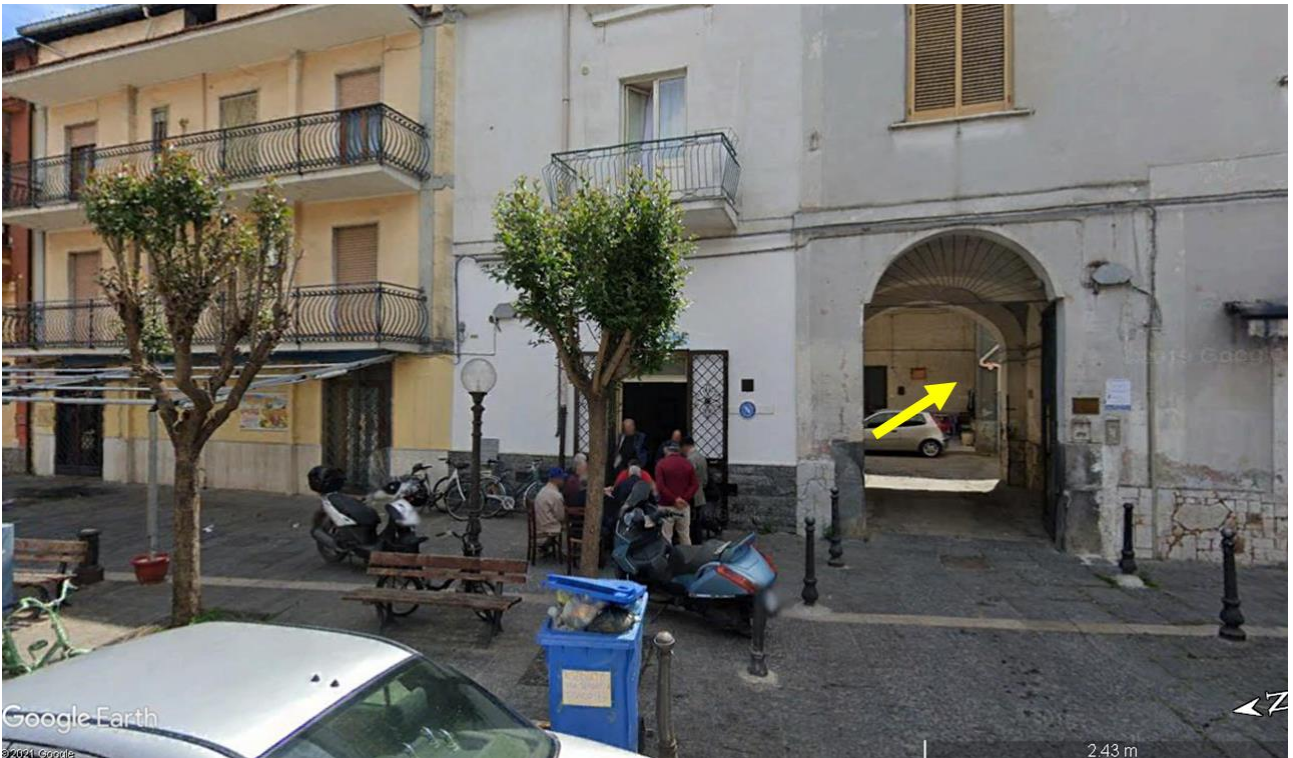
Fig. 5 - La freccia indica il fabbricato, retrostante all'androne di portone, ipotizzato come palazzo baronale.
